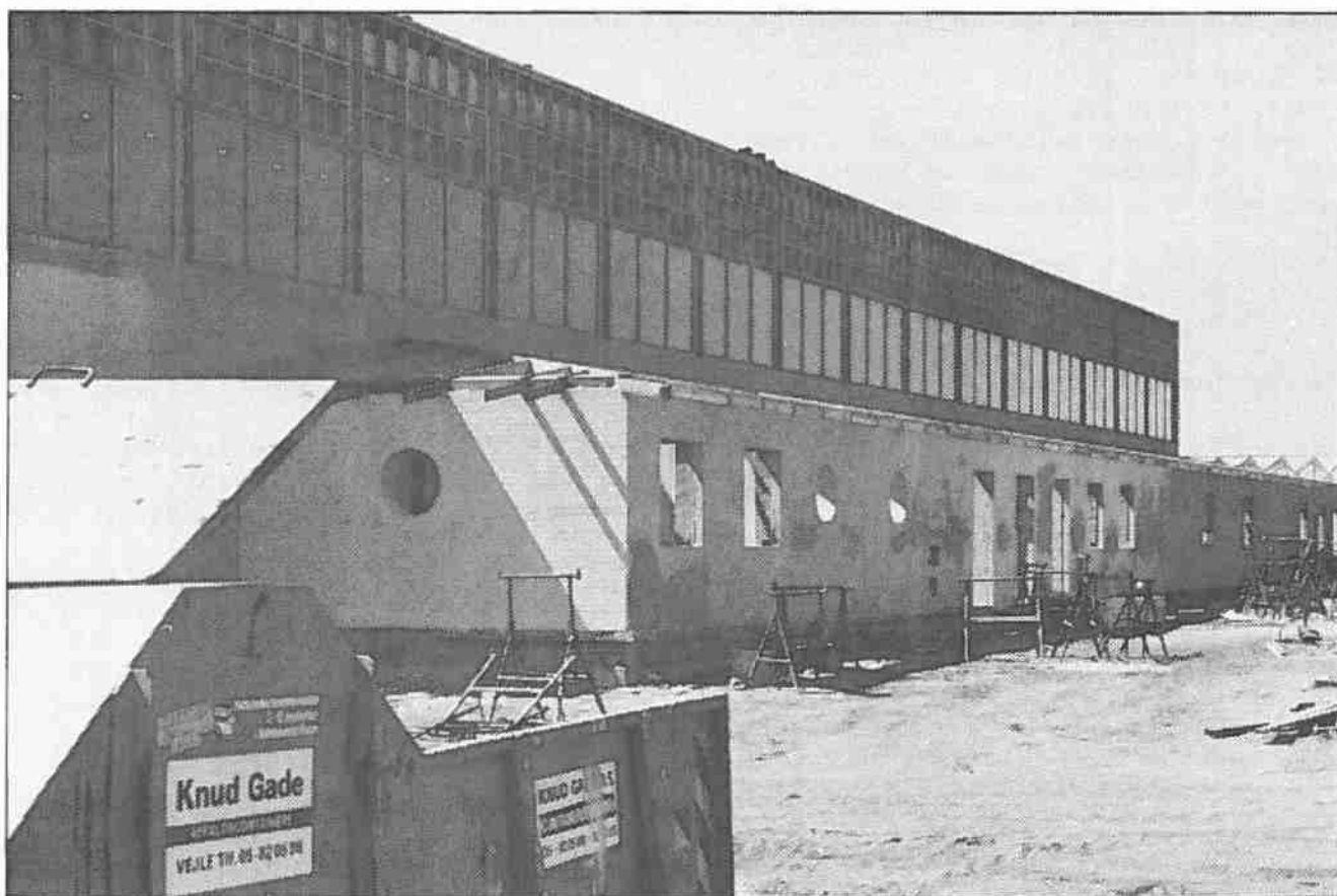
Hangarhallen set fra nordsiden. I en anden artikel i bladet vil man kunne læse, om hangarens videre skæbne.
