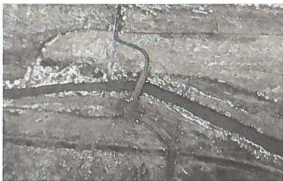
»Low-Level-Recce« piloten har afsløret et brobygningsarbejde
