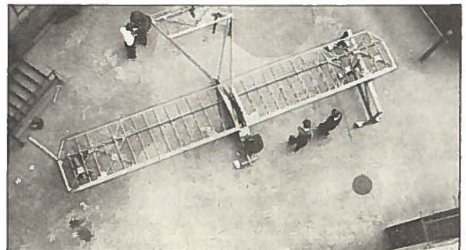
DL3 under Bygning.
