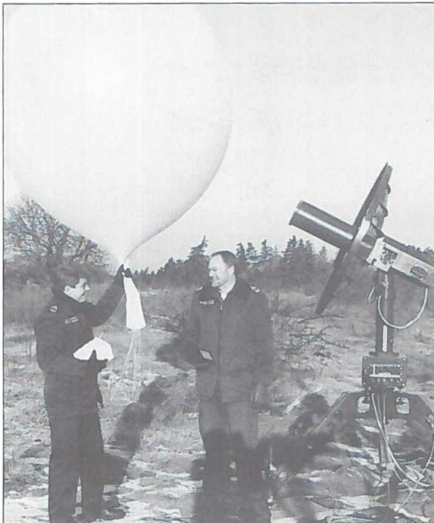
I koldt klar forårsluft er oversergent P.G. Farcinsen og lederen af Radiosondetjenesten i Flyvertaktisk Kommando, seniorsergent Keld Bødker klar til at sende en radiosonde op i 30 kilometers højde.
