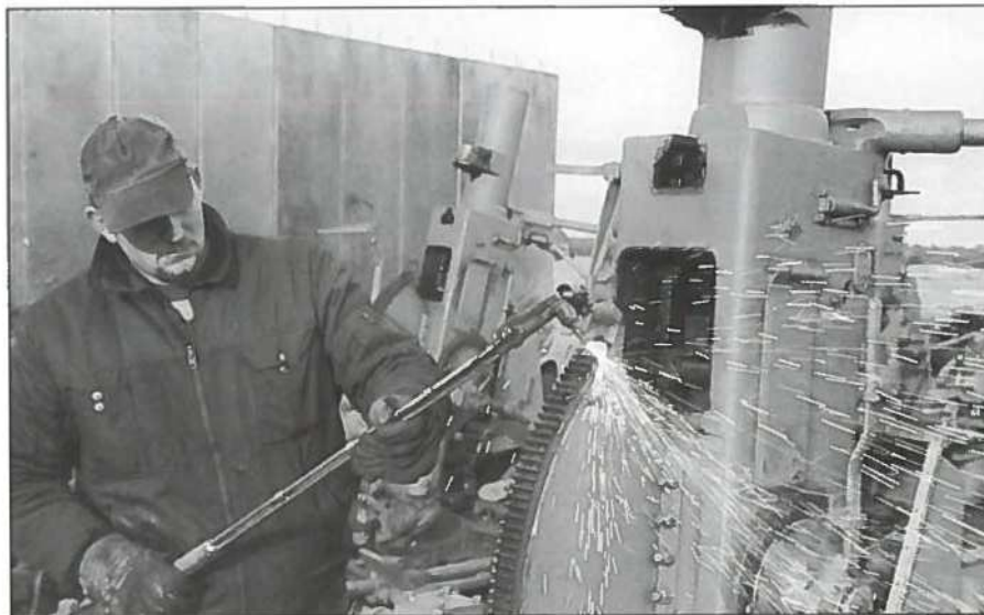
Michael Axelsen fra „Orla's Produktforretning“ i Bjerringbro er her i færd med at skære lavetterne til de 54 gamle håndrettede L/60 40 mm antiluftskyttskanoner i passende småstykker.
