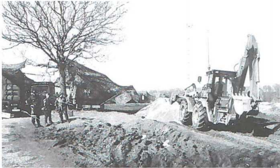
I nøden skal man kende sine venner. Her er det en gummiged fra Ingeniørtropperne, der er i gang med at lægge stabilgrus ud. I løbet af et par timer var et pløret spor ændret til en fin grusvej.
