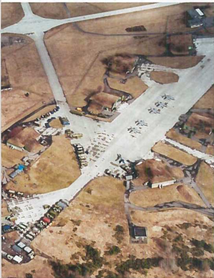
„Felten. Bygningerne ude ved banen er fra højre kontrollårnet, og 90% relativ fugtighed. I bunden af billedet ses eskadrilledet hele udseende af noget, der kan holde i årevis. At der kun eks fly skyldes, at et står i shelter til reparation.
